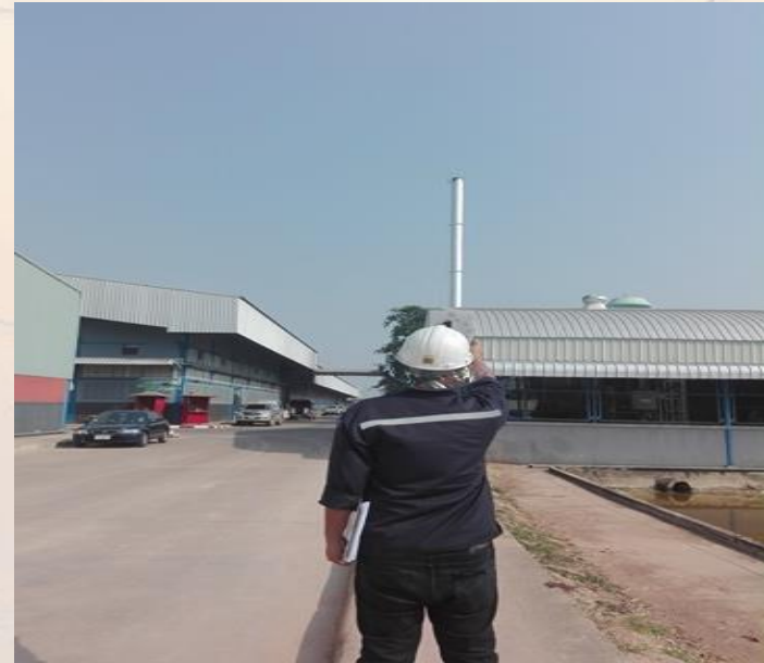
ปล่อง Boiler
